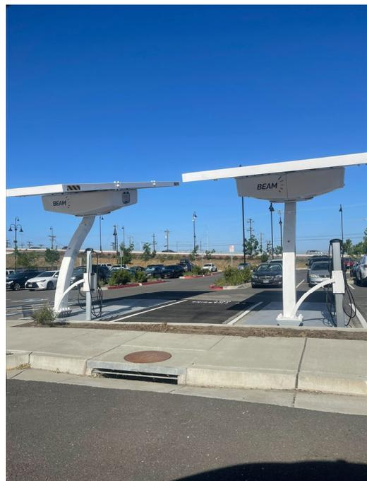
Las unidades pueden generar y almacenar suficiente electricidad solar limpia para cargar hasta 265 millas en un solo día, y las capacidades de almacenamiento de baterías permiten que carguen vehículos eléctricos tanto de día como de noche. Cada unidad tiene dos dispensadores de carga de vehículos eléctricos y la electricidad producida es limpia y renovable.
